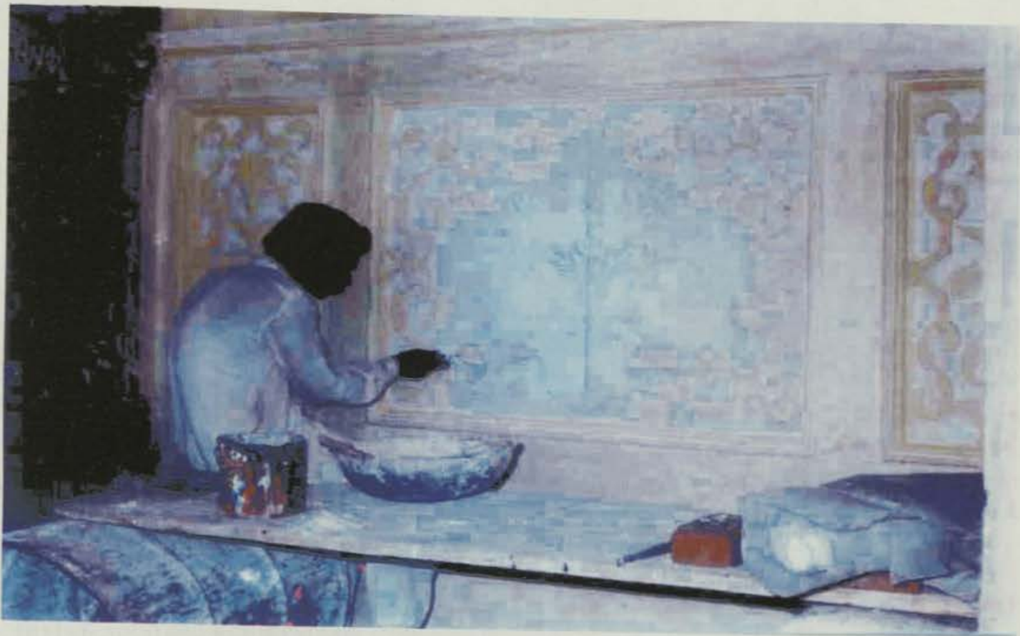
Pl. 138 Adding mortar for relief stucco.
